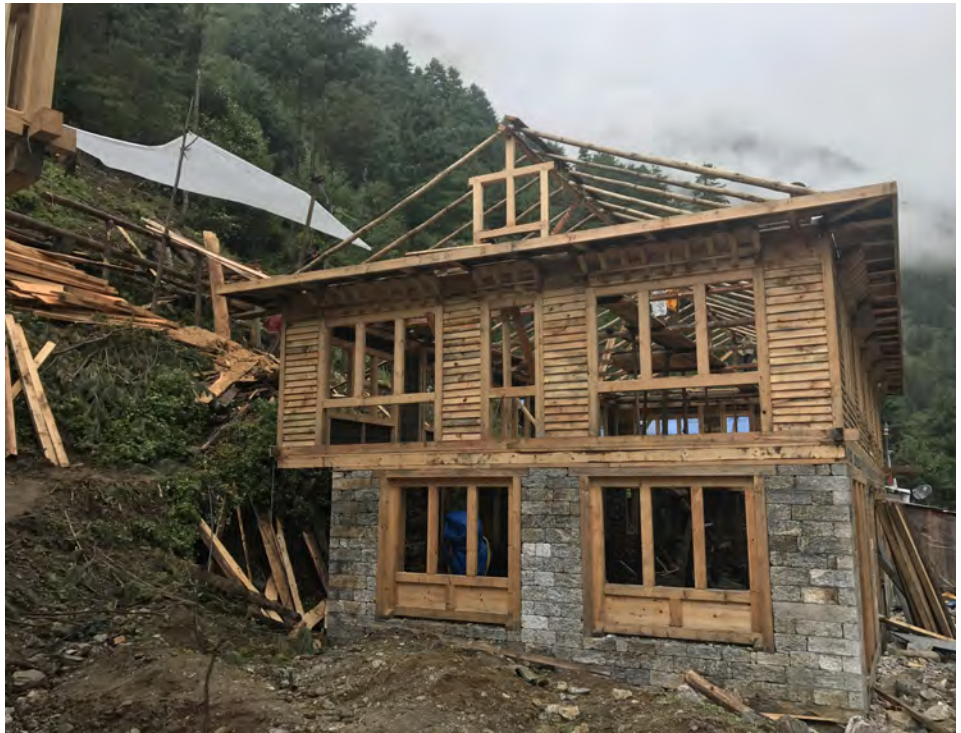
Abbildungen 3 & 4: Holz und vorgefertigte Materialien werden für die Strukturen des ersten Stocks verwendet; Figure 3 & 4: Wood and pre-fabricated materials in construction. Quelle/Source: Tommy Gustafsson, 2021
